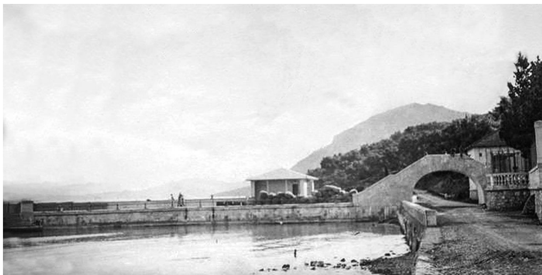
Η πλήρης Γέφυρα
